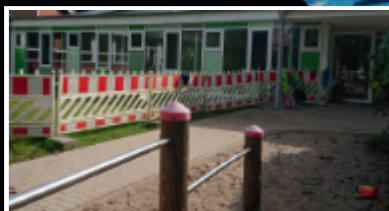
Kita - saniert und erweitert
